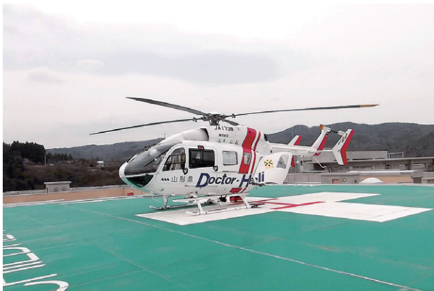
屋上ヘリポート
