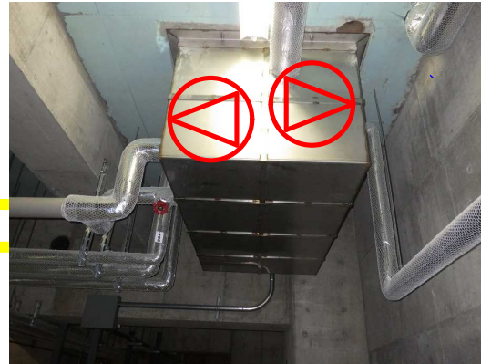
ちか地下タンク
