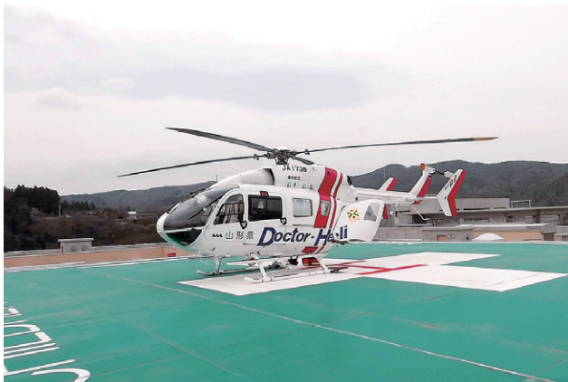
屋上ヘリポート
