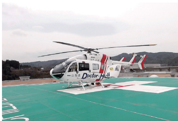
屋上ヘリポート
