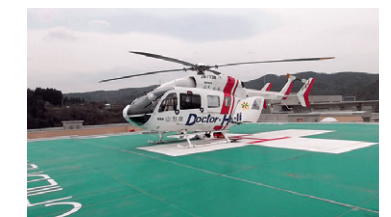
屋上 ヘリポート
