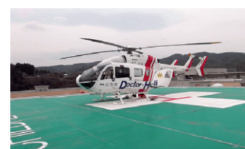
屋上 ヘリポート
